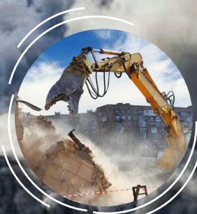
Chantier de démolition
