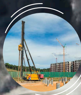
Battage de pieux
