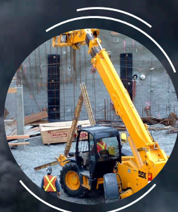
Chantier de construction
