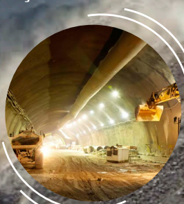
Escavação de túneis
