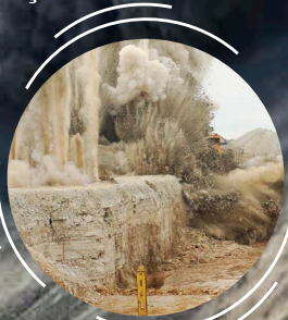
Explosão (minas, túnel)
